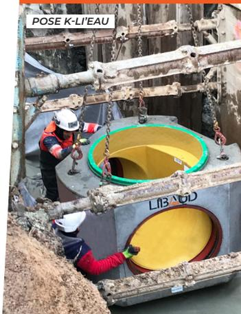
REGARDS **K-L'EAU** ÉQUIPÉS DE MANCHONS FONTE PH1 DN600 ET DN800, INTÉGRÉS À LA FABRICATION, POUR UNE SOLUTION COMPLÈTE TUYAU-REGARD-TAMPON RÉSISTANTE AU PH1
