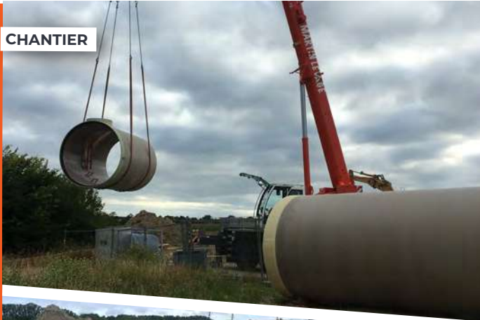
POSE DU PRV DN2400
