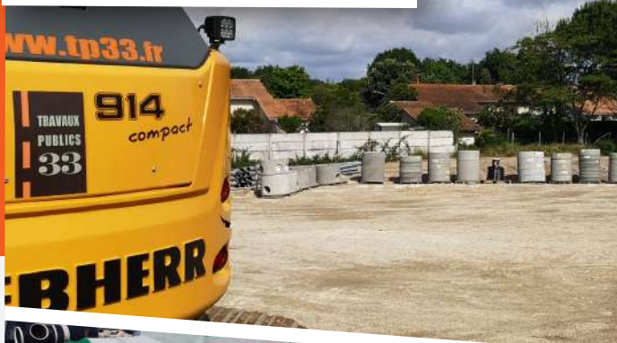
PLATEFORME DE STOCKAGE CHANTIER
